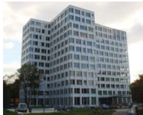
Intelligent geplante Fassade: Ein Bürohochhaus am Bennigsenplatz in Düsseldorf.
