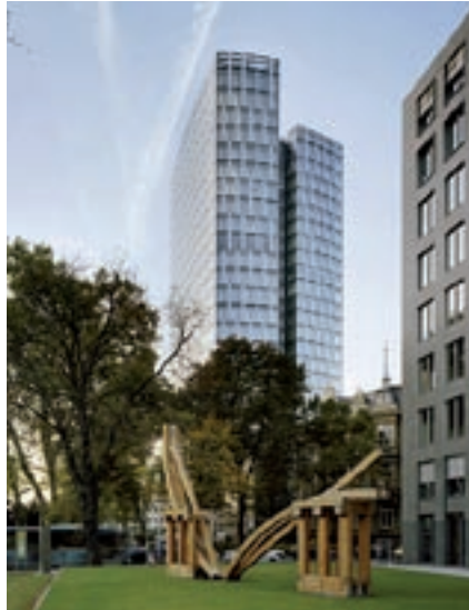
Westend-Duo (Frankfurt a. M.): Doppelfassade mit integrierten Lüftungsboxen.
