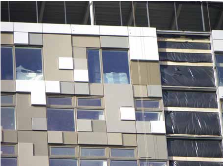
Metallfassade mit unterschiedlich gefärbten anodisierten Blechbekleidungen
