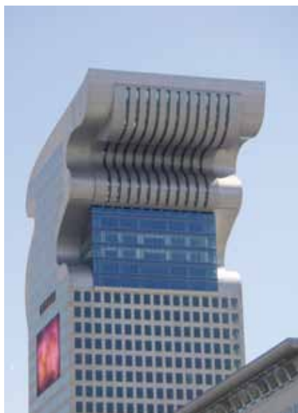
Hochhaus in Peking mit fehlender Befahranlage zur Reinigung der Fassadenbekleidungen.
