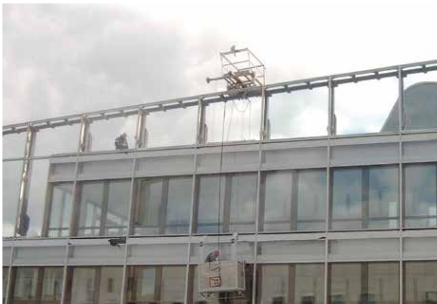
Bild 1 – Beispiel schräge Fassadenbefahranlage.
