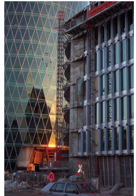
Facettierte Reflexion unterschiedlich geneigter Scheiben.
