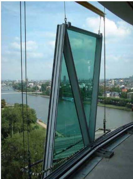
Montage der Elementfassade am Westhafen Tower.
