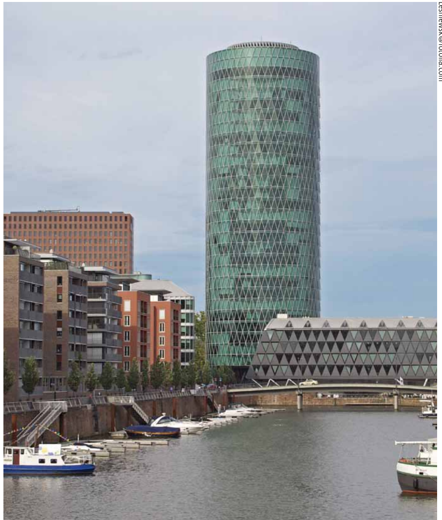
Der Westhafen Tower fungiert als weithin sichtbares Eingangstor zur City Frankfurt.
