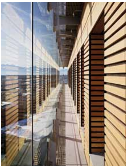
Korridor in der Doppelfassade
