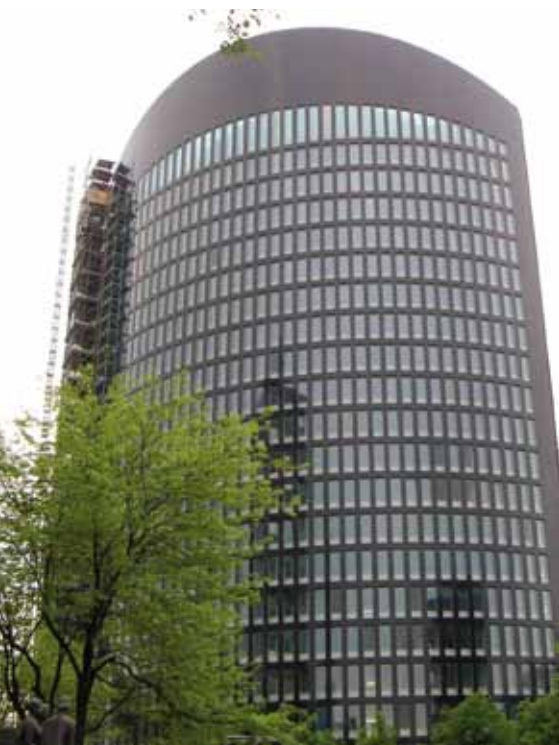
Komplexe Elementfassade am RWE-GAS-TOWER, Dortmund (Architekt: Prof. Gerber).
