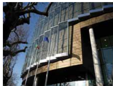
Mit Unterstützung von AMP realisiert: Der Criminal Courts Complex (Dublin) verfügt über eine Mehrschicht-Fassade mit automatisch gesteuerter Durchlüftung.
