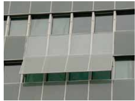
Abbildung 2: Windsicheres Sonnenschutz-Glasschild mit 400 V Zahnstangen-Antrieben. Das Glaschild kann ca. 1,8 m aus der Parkstellung im Bereich der Brüstungen nach unten vor die transparenten Fensterelemente gefahren werden. In der unteren Endstellung kann das Glaschild zusätzlich nach außen geschwenkt werden.
