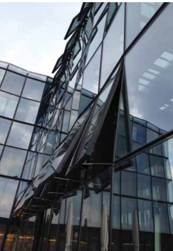
Abbildung 4: „Jumbo“-NRWG-Klappfenster mit Hydraulik-Antrieben; Größe ca. 2,7 m x 4,1 m (B x H).
