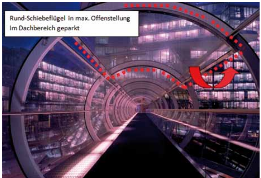
Abbildung 3: Elektro-mechanischer Öffnungsmechanismus für die seitliche Belüftung einer Glasröhre. Einzelne gebogene Glassegmente können mit Hilfe eines Getriebemotors und mit einem in die gerundeten Pfostenprofile verdeckt eingebauten Beschlag stufenlos in den Dachbereich der Glasröhre gefahren werden.
