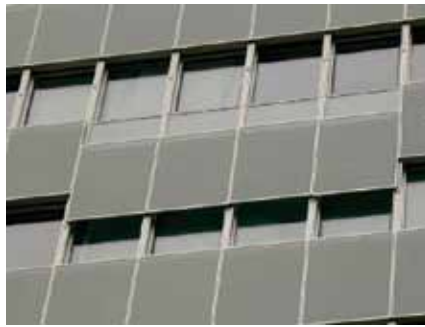
Abbildung 2: Windsicheres Sonnenschutz-Glasschild mit 400 V Zahnstangen-Antrieben. Das Glaschild kann ca. 1,8 m aus der Parkstellung im Bereich der Brüstungen nach unten vor die transparenten Fensterelemente gefahren werden. In der unteren Endstellung kann das Glaschild zusätzlich nach außen geschwenkt werden.
