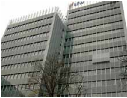
Abbildung 2: Windsicheres Sonnenschutz-Glasschild mit 400 V Zahnstangen-Antrieben. Das Glaschild kann ca. 1,8 m aus der Parkstellung im Bereich der Brüstungen nach unten vor die transparenten Fensterelemente gefahren werden. In der unteren Endstellung kann das Glaschild zusätzlich nach außen geschwenkt werden.
