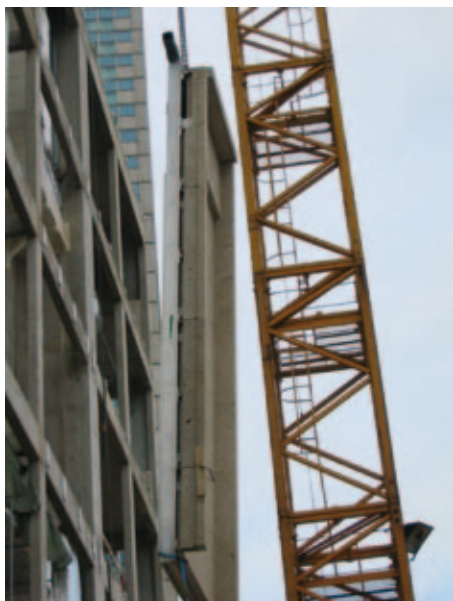
Anlieferung eines Naturstein-Fassadenelements
