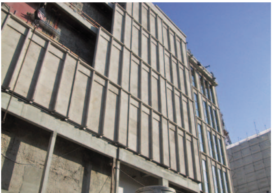
Elementierte Naturstein-Fassadenkonstruktion an einem Kaufhaus.
