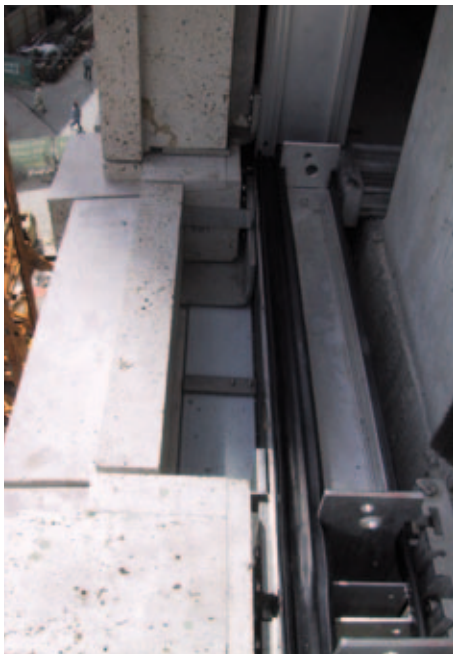
Aufbau einer Natursteinelementfassade im Detail
