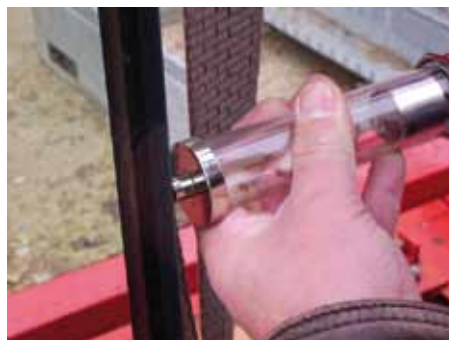
Bild 5+6: Restsauerstoffmessung an der Baustelle.
