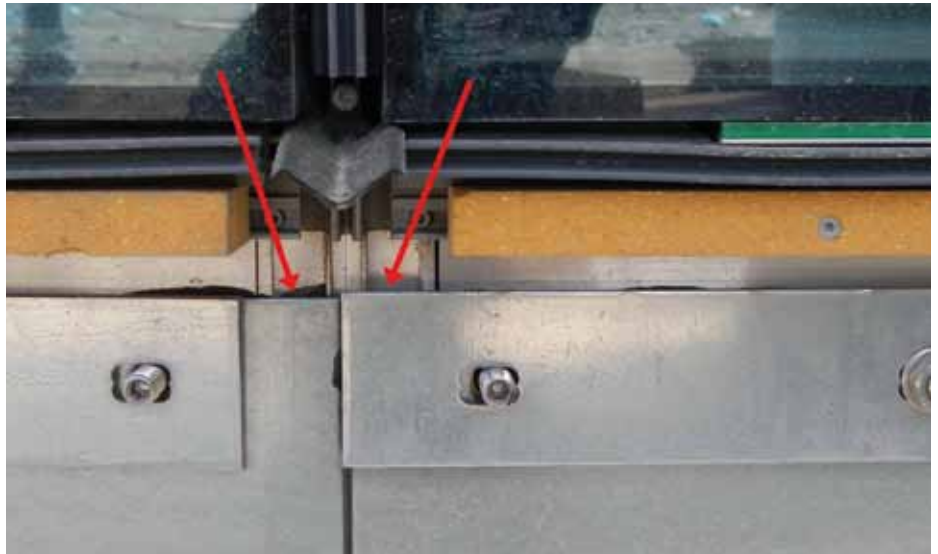
Bild 3 – Klemmprofil-Anschluss vor Pfosten – notwendige Abdichtung
