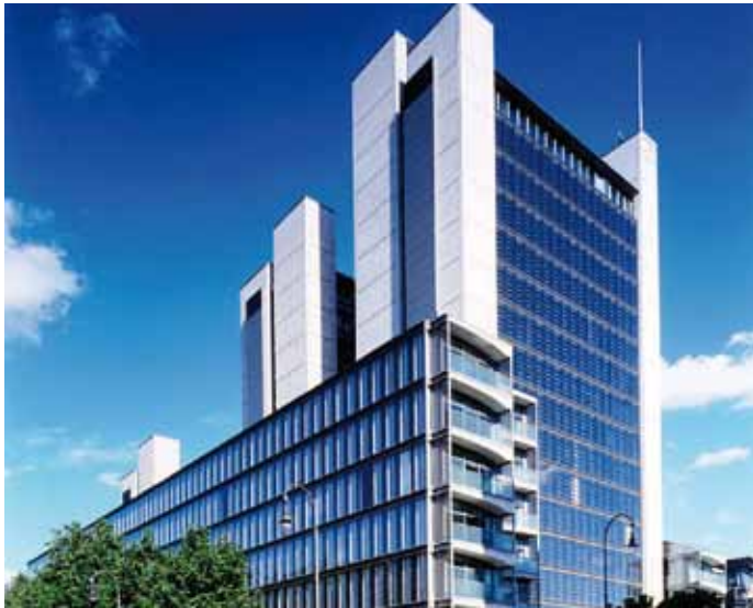
Jalousie im Isolierglas integriert: Das Gerling Ring Karree (Köln).
