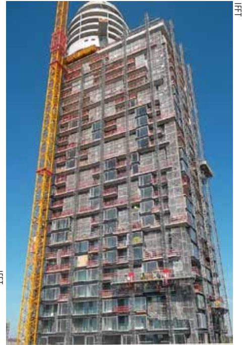
Wohnhochhaus Westseite Blick nach oben zum „Fass“.
