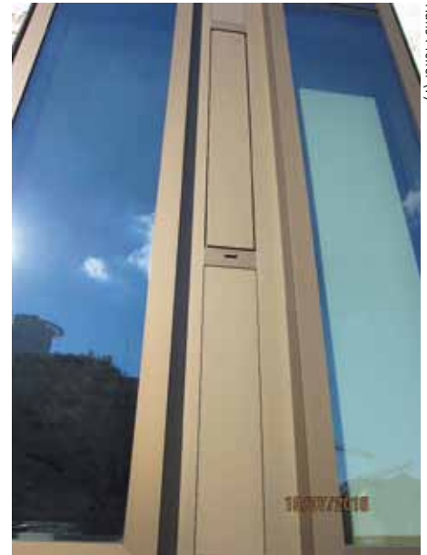
Bild 2: Die Farbunterschiede in den kleineren Querriegeln gaben den Anstoß zur Mangelanzeige.
