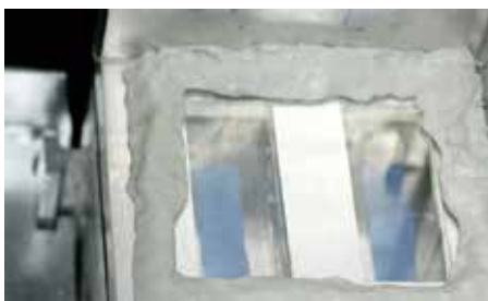
Sichtfenster in Profilflanke.
