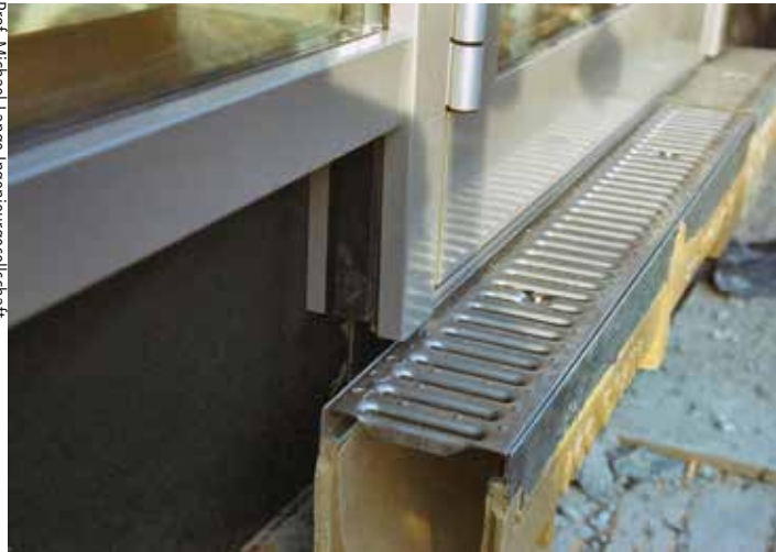
Eine klassische Entwässerungsrinne vor einer Außentür im Bauzustand.
