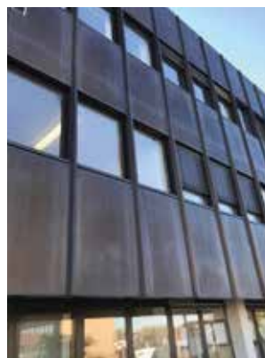
Bild 1: Ausgangszustand der Fassade.
